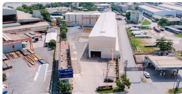
KHO 382 HÙNG VƯƠNG No. 382 Hung Vuong Warehouse
