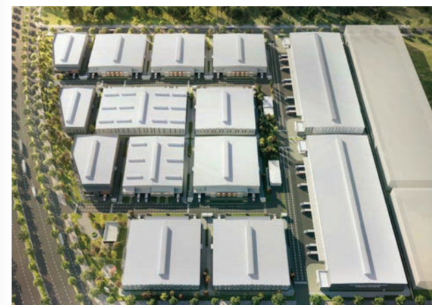
NHÀ MÁY TITAN - BẮC NINH Titan Factory - Bac Ninh
